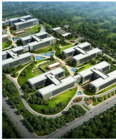
西安华为数据中心
